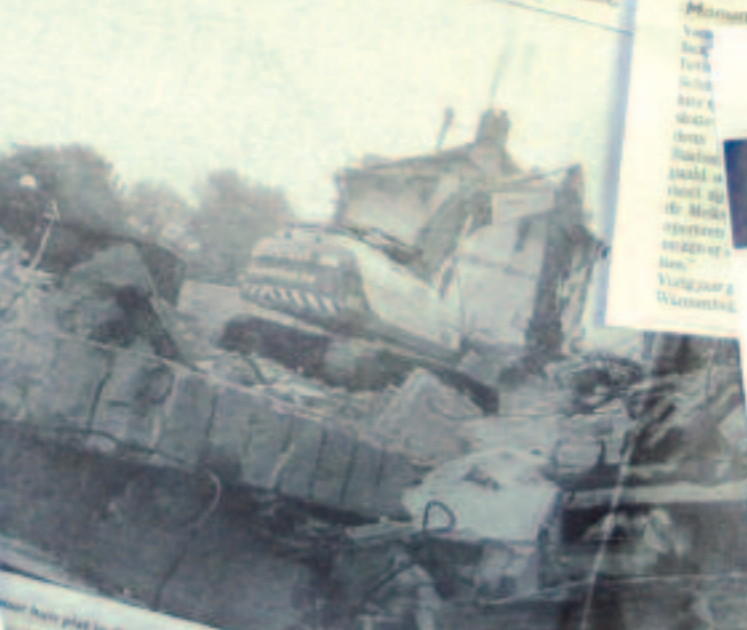
De afgebroken delen van een gebouw worden afgevoerd.
