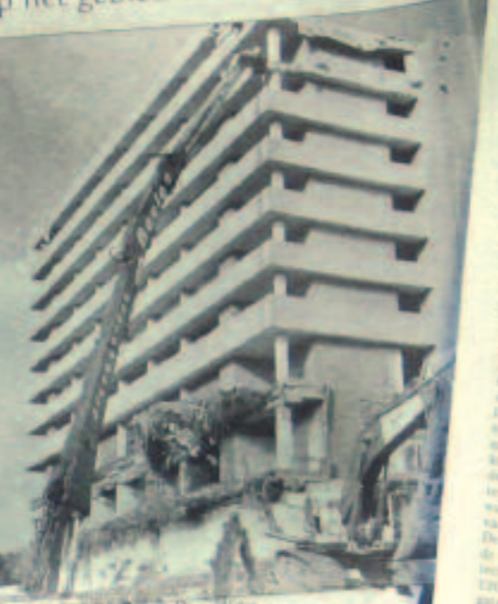
De sloop van een groot gebouw in Haarlem. De afgebroken delen worden afgevoerd.
